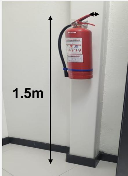
**01** Los extintores deben ubicarse a una altura entre **10 cm a 1.5 m** máximo.
