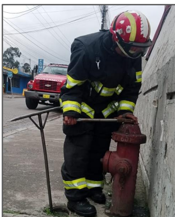
Gráfico 18. Apertura de válvula de paso de hidrante
