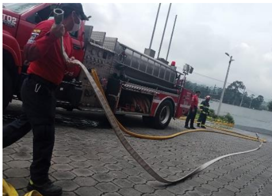
Gráfico 28. Extendido de manguera
