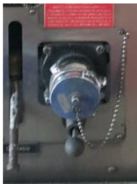
Gráfico 31. Toma de hidrante de la autobomba
