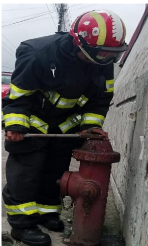
Gráfico 27. Apertura de válvula de paso de hidrante
