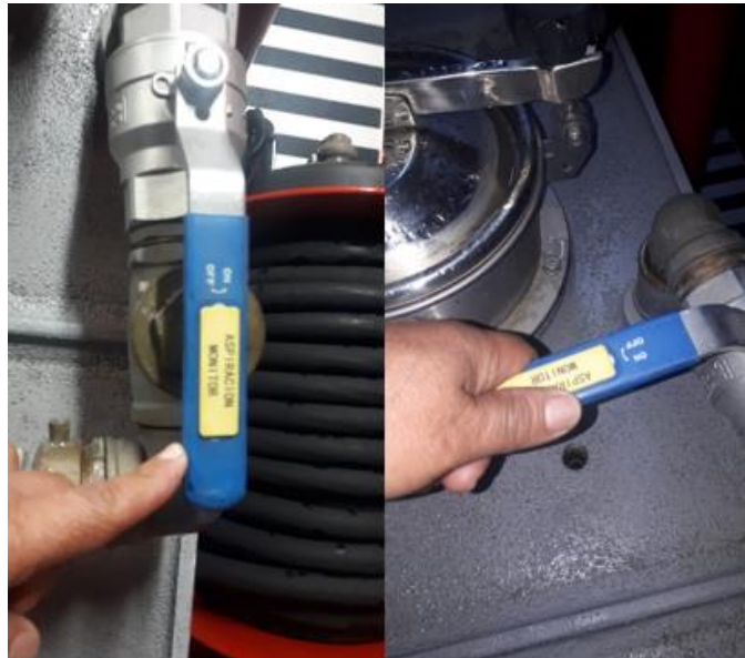
Gráfico 47. Apertura de válvula de espuma
