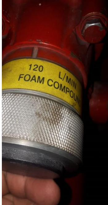
Gráfico 45. Apertura de dosificador de espuma a 120 l/min
