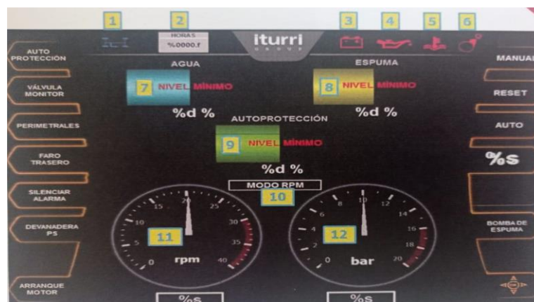
Gráfico 42. Verificación de presión en panel de control
