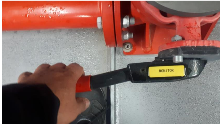
Gráfico 52. Apertura de válvula de paso de monitor
